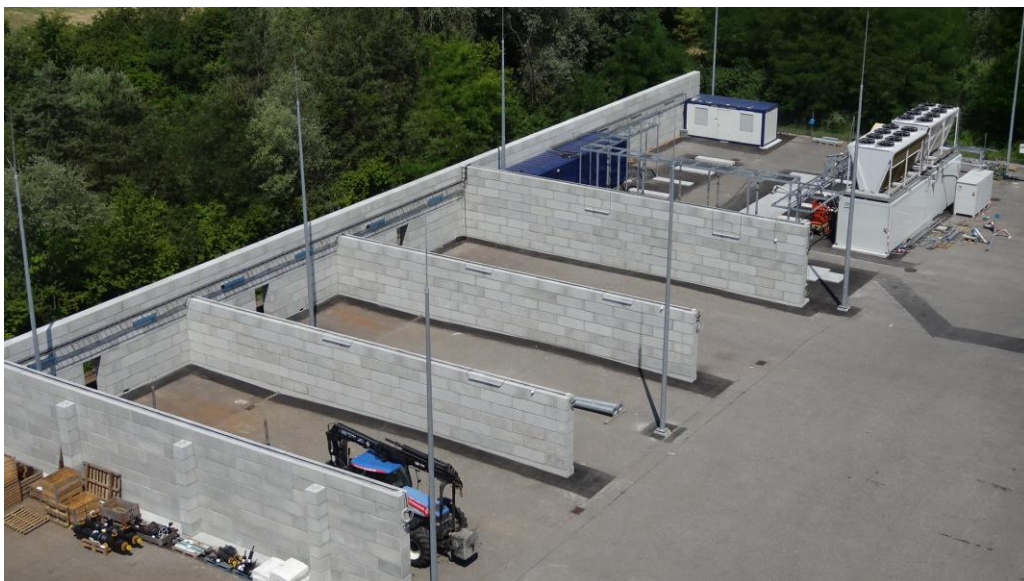
Bildlegende: Die Fundamente für die Wasserstoffproduktionsanlage sind erstellt.
